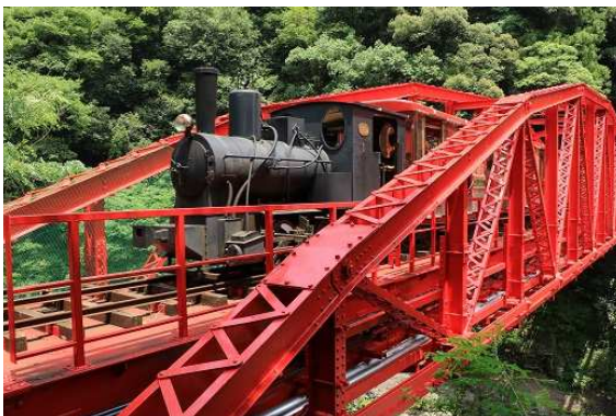
端出場鉄橋・鉱山鉄道
