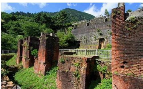
東平貯鉱庫・索道基地跡
