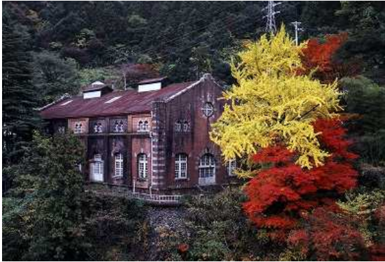
旧端出場水力発電所
