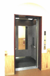
2Fエレベーター
