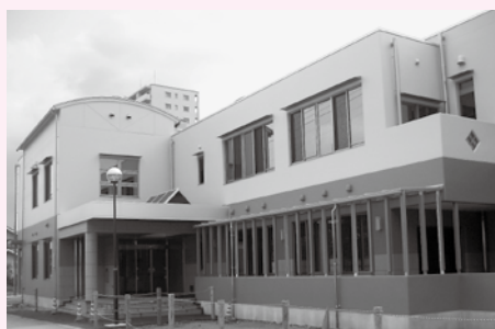
■ 地域交流センターの建設
