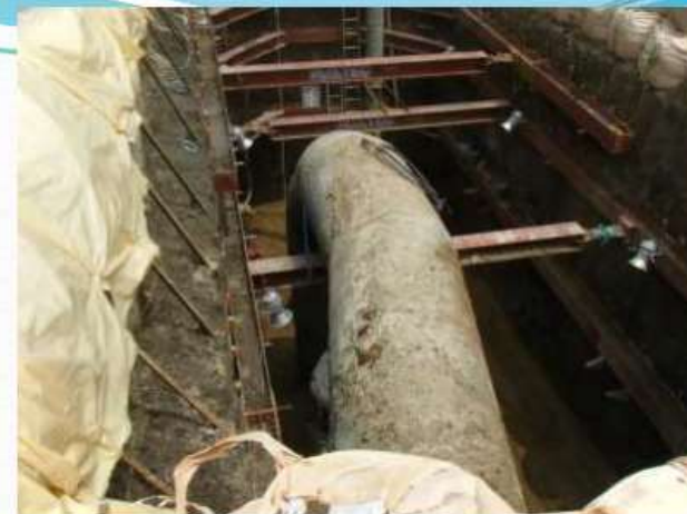
熊本市内Φ1350mm基幹管路の修理
