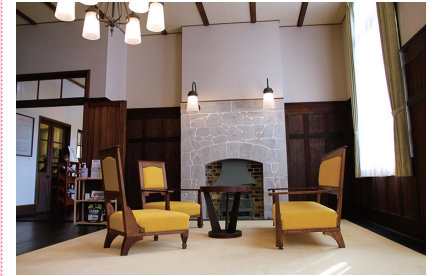
応接室でひときわ目を引く石造りの暖炉は、大島石を使用。張りものではなく、奥行きのある石が埋め込まれている。取解きにより、移築後も石の並びは変わっていない。
