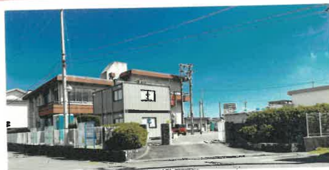
小学校の頃の通学路にある滝宮送水場
