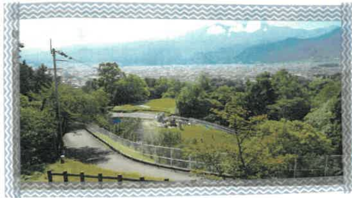
金子山配水池
