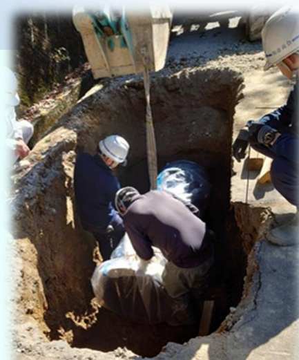
〈配水管耐震化工事の様子（川西地区）〉
