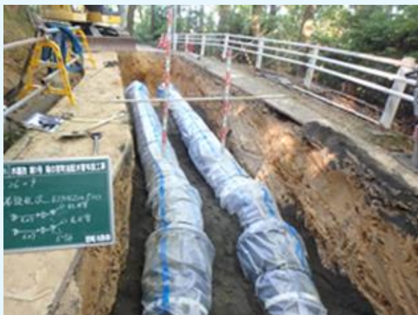
金子山配水池送・配水管耐震対策
