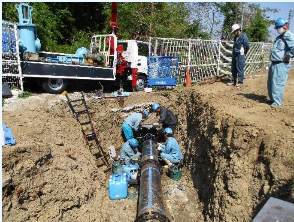
篠場送水管耐震対策
