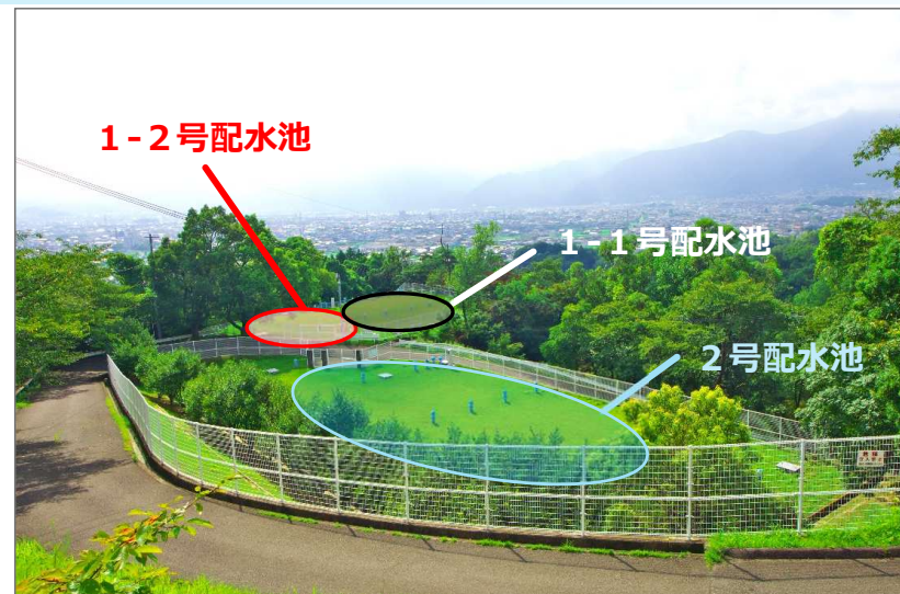
【2号配水池の北側から見た金子山配水池】
