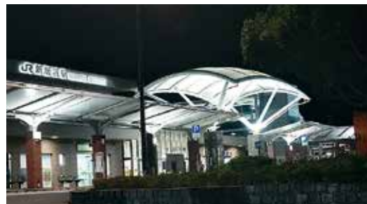
市内照明灯(1,003灯)のLED化を実施。
