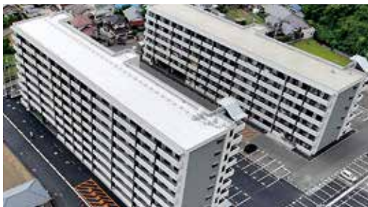
東田市営住宅(2号棟)を建設。
