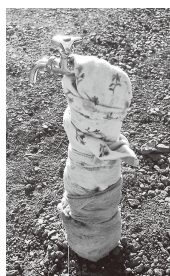
凍結防止対策でタオルを巻き付ける
