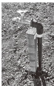
凍結防止対策でタオルを巻き付ける
