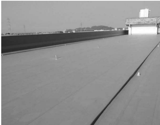
南中学校北棟
