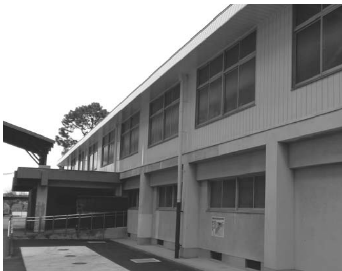
高津小学校体育館
