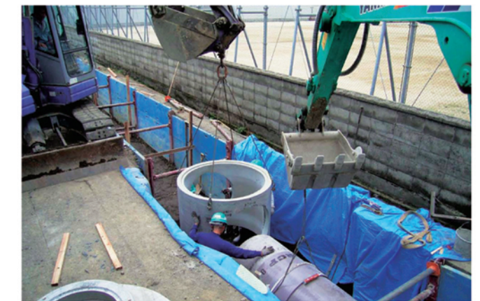
④ 下水道工事
