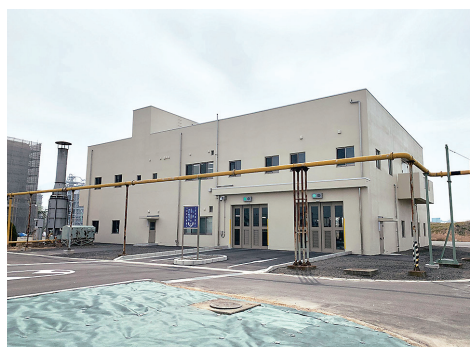
浄化槽汚泥等受入施設
