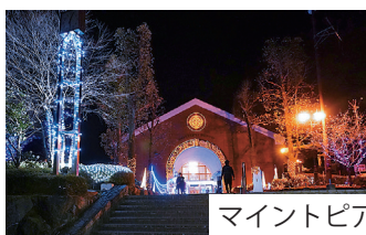
旧端出場水力発電所
