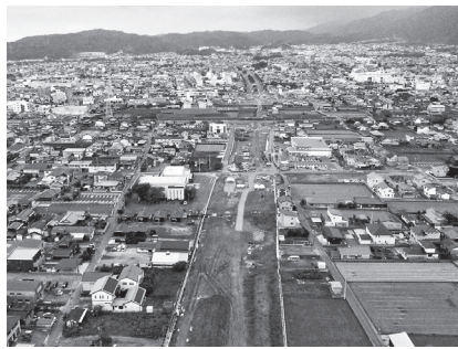
国道11号新居浜バイパス整備状況 (本郷～西喜光地町間)
