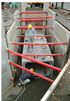
雨水管布設工事
