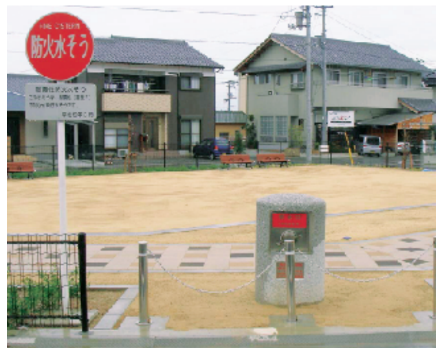
■防火水槽設置状況
