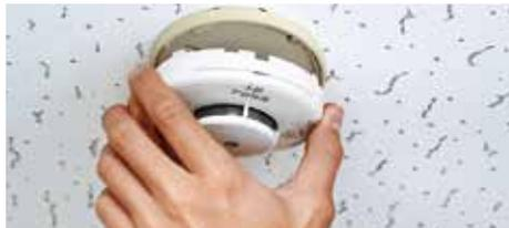
住宅用火災警報器を設置面に軽く押し付けながら、左に回し取り外す。（取り付けベースは設置面に残す）。
