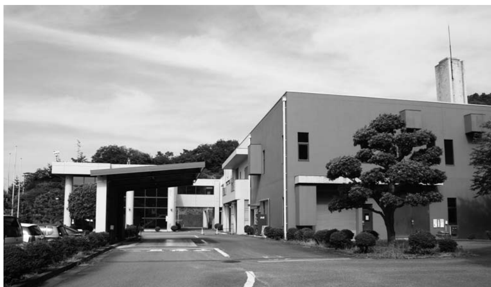
衛生センター
