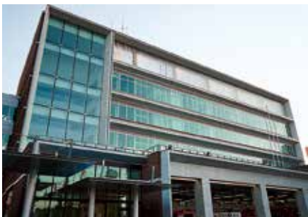
総合防災拠点施設建設事業 43 億 1,997 万円 災害対策本部機能および消防本部機能などを有する消防防災合同庁舎が完成しました。
