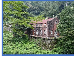
④ 旧端出場水力発電所
