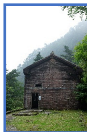
⑫ 東平第三変電所跡
