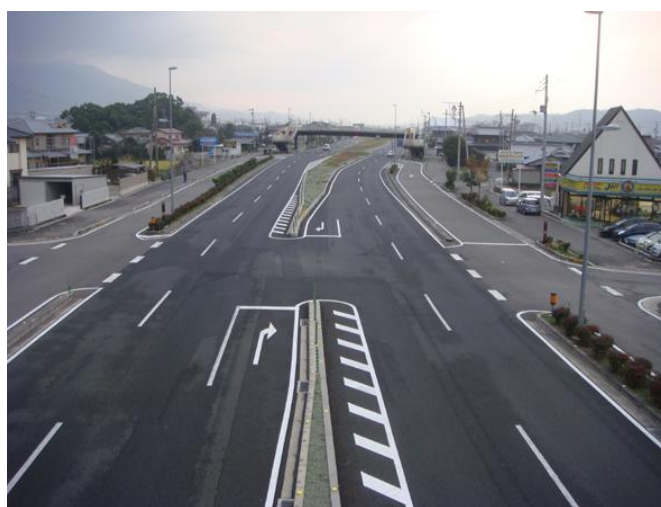
▲ 整備が進む国道 11 号線新居浜バイパス
