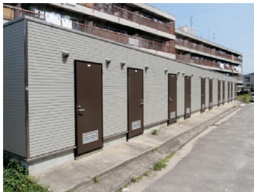
▲新しく改修された市営住宅の外部物置
