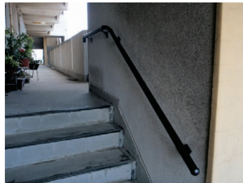
▲市営住宅の共用階段に整備された手摺
