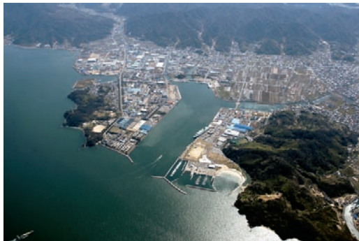
▲新居浜港東港地区
