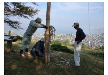
11/7 電飾支柱設置
