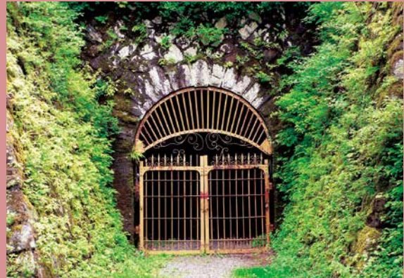
旧第三通洞（明治35年）
