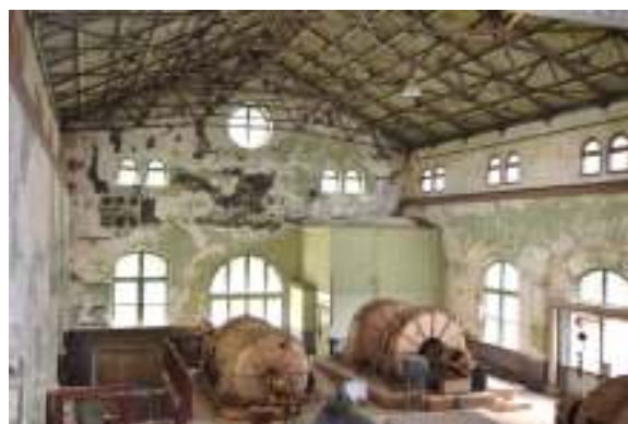
写真3-2 建物内部 西面
