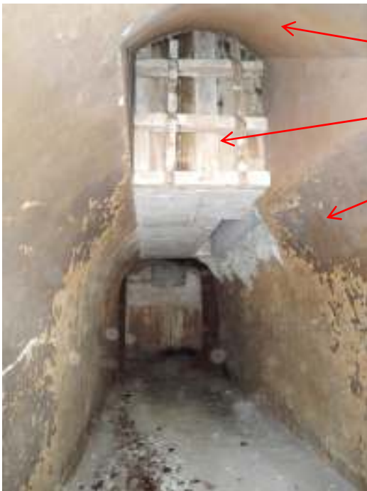
FC1,2 風洞（旧第三水車発電機排水路） 第三水車発電機部分
