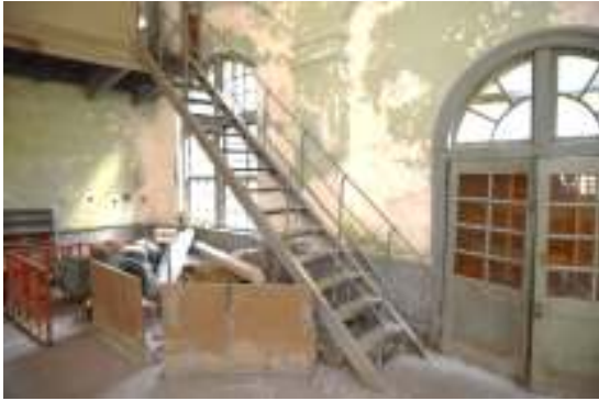
写真 3-28 当初階段の転用
