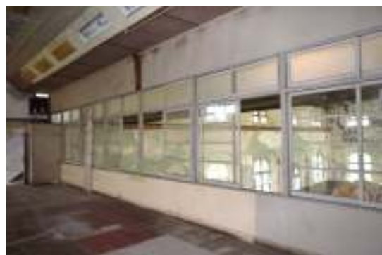
写真 3-15 配電盤室 2階西面
