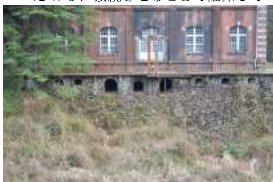
写真 3-43 足谷川の対岸から石垣を見る
