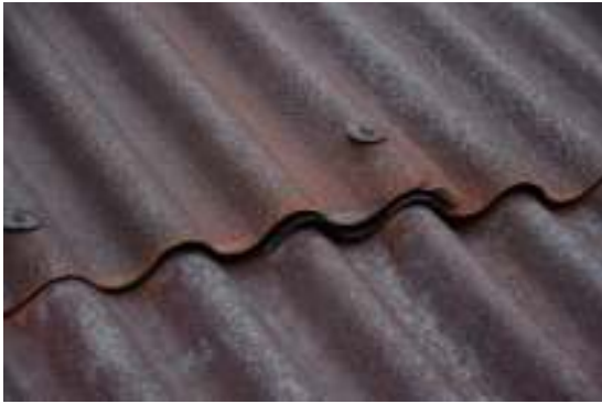
写真 3-5 波形鍍鉄板葺
