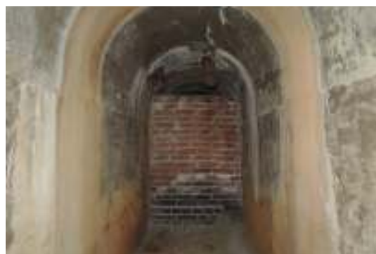
写真 3-50 W-2 内部の煉瓦塀
