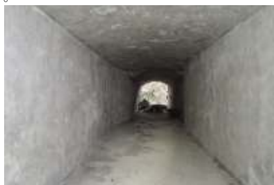
写真 3-44 A-4 内側から外部を見る
