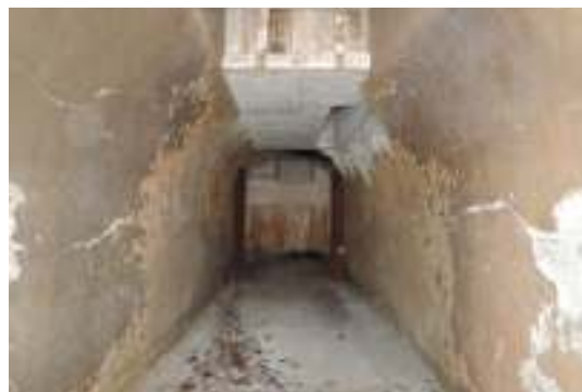
写真 3-48 W-3 を石垣側から内部を見る
