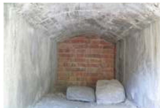
写真 3-46 A-8 石垣側から内部を見る
