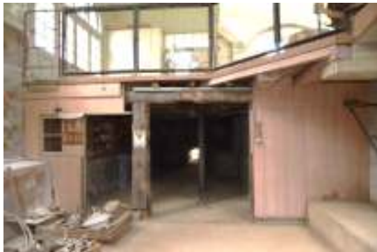
写真 3-18 旧特別高圧室 北面
