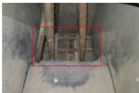
写真 3-45 A-6 が封鎖されている様子
