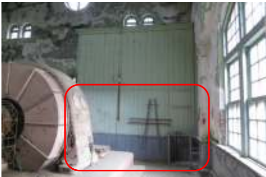
写真 3-30 事務室東側壁面
