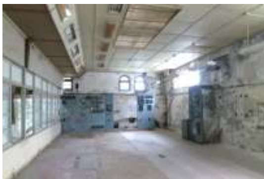
写真 3-14 配電盤室 2階南から北を見る
