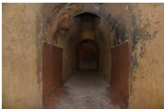
写真 3-49 W-1 を石垣側から内部を見る
