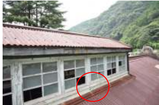
写真 3-35 越屋根延長増築痕跡
