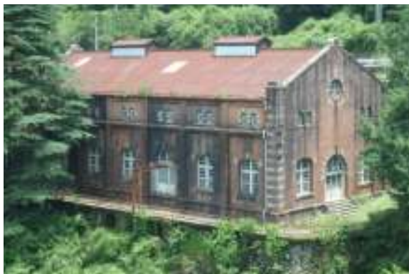
写真3-1 建物外観 北西面
