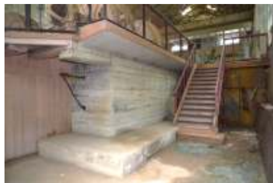
写真 3-33 旧特別高圧室 後設壁
