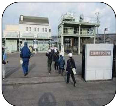
ポンプ場見学
