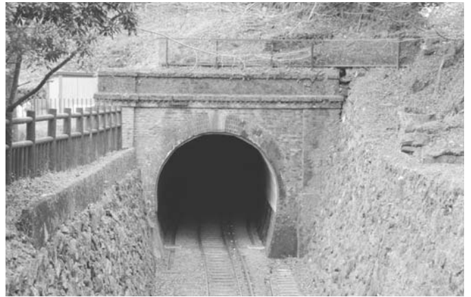
旧別子鉱山鉄道端出場隧道
