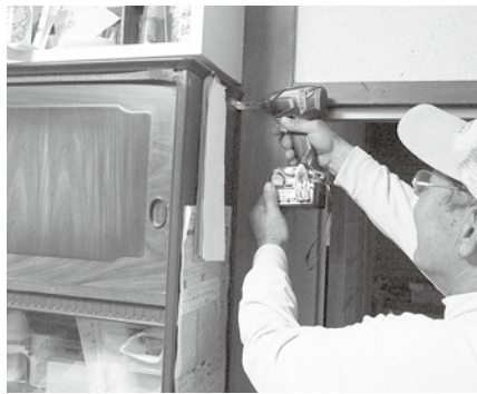
家具固定器具取り付け作業の様子
