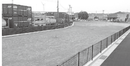
新居浜駅南駐車場建設現場
